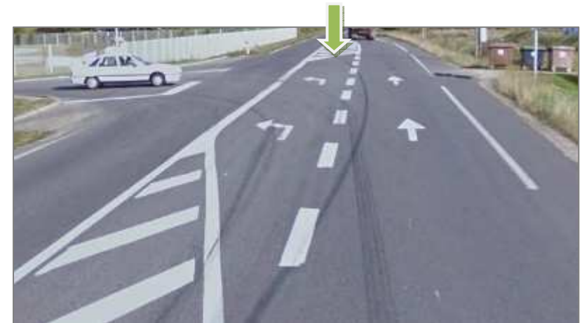
Création d'un tourne à gauche vers le Barail des Jais
