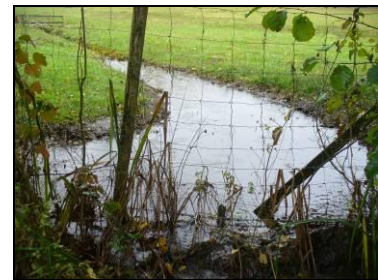
Exutoire sur la parcelle privée
