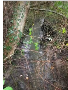
Amont du pont
