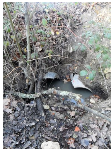
Buse côté aval
