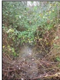
Aval du pont
