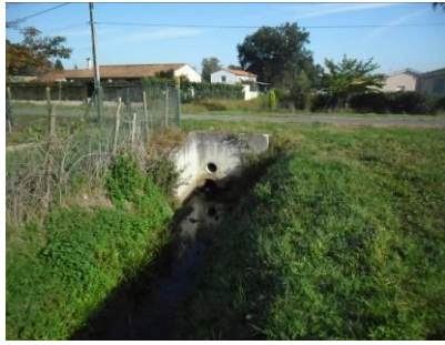
Fossé en amont
