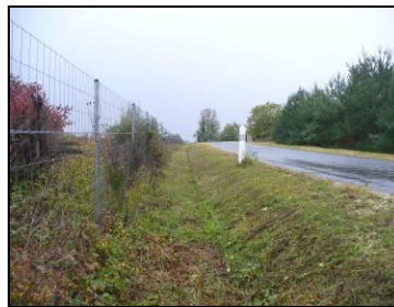
Fossé en bordure d'autoroute
