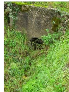
Buse bouchée en amont
