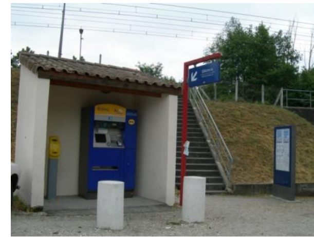
Photo 9: Halte ferroviaire de Saint-Denis-de-Pile
