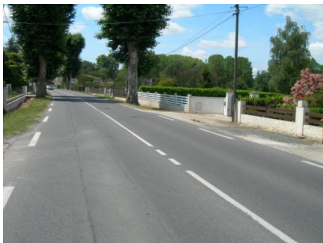
Photo 27: Accotement réduit et présence d'obstacles saillants (arbres, fossés, etc) en bordure de chaussée sur la RD 910 en sortie de bourg
