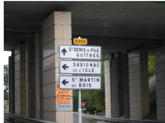
Photo 35: Passage sous voie pour les transports exceptionnels sous l'ouvrage d'art de l'A 89
