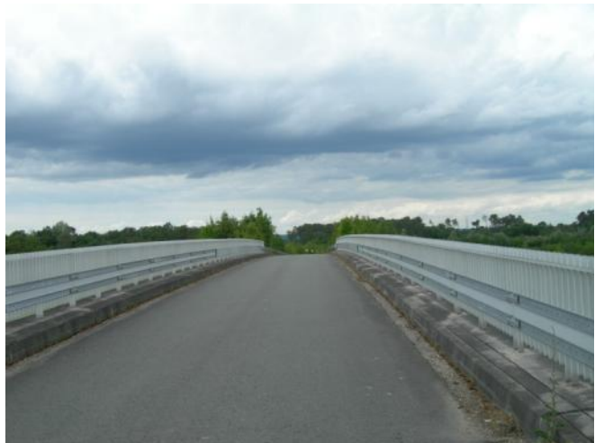
Photo 40: Ouvrage de franchissement de l'A 89 par le Chemin des Moines
