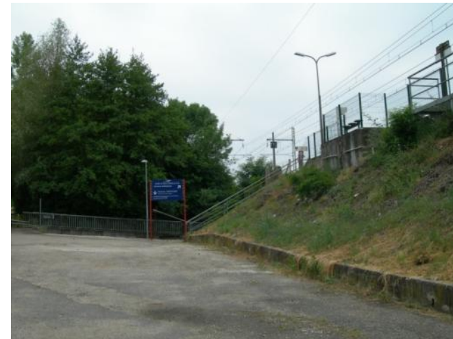
Photo 32: Halte ferroviaire de Saint-Denis-de-Pile
