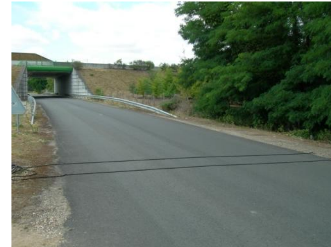
Photo 37: Passage sous ouvrage sur la RD 245 - Route de Robin
