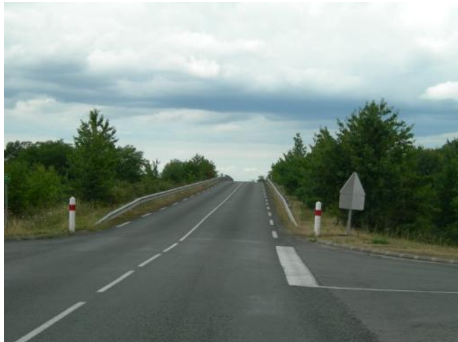
Photo 39: Ouvrage de franchissement de l'A 89 par la RD 22 (Route de l'Europe)
