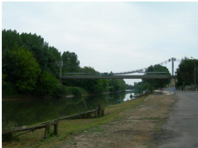
Photo 30: Franchissement de l'Isle (Rue du Pont - RD 22)
