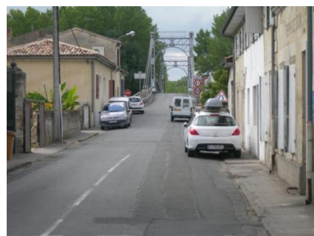
Photo 46: Véhicules stationnés Rue du Pont avant le franchissement de l'Isle
