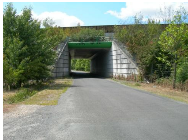
Photo 36: Passage sous l'ouvrage de l'A 89 sur la Route de Saint Émilion
