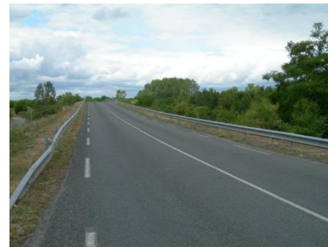
Photo 38: Ouvrage de franchissement de l'A 89 par la Route de Coudreau
