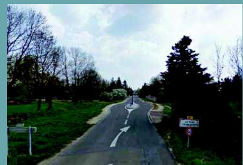
Chicane avec îlot central en entrée d'agglomération
